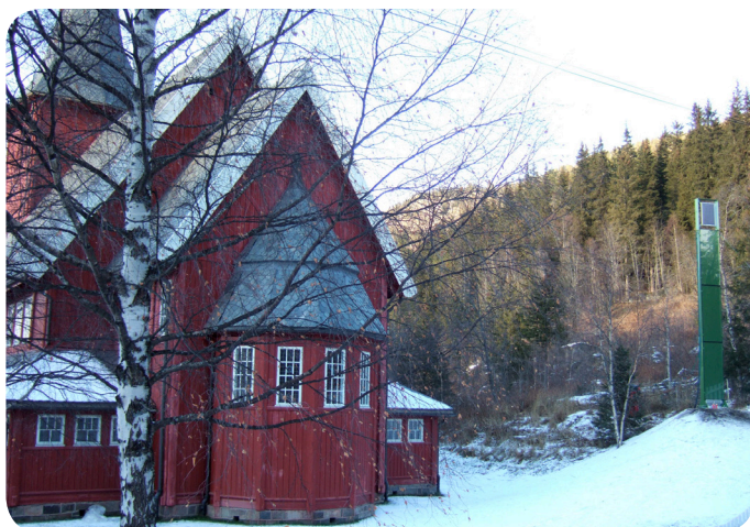
Hol kirke ble bygd i 1924. Tak og vegger er av tømmer uten tilleggsisolering. Tiltak for å minke energibruken og høyne komforten skal ikke være synlige. Arkitekt for energitiltakene: Harald N. Røstvik AS.
